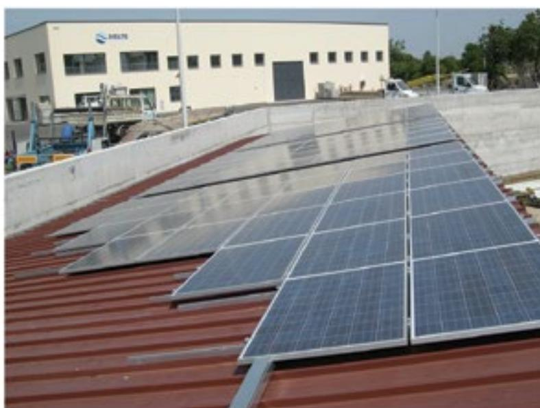
Impianto fotovoltaico di 20 Kw installato presso lo stabilimento
