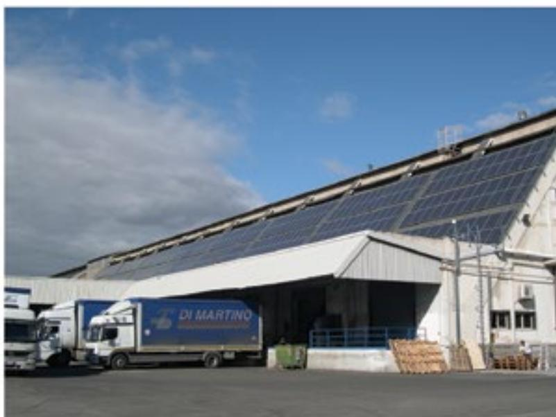
Impianto fotovoltaico di 100 Kw installato presso lo stabilimento
